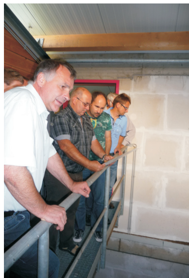
Mitglieder des AK Nahwärme besuchen Heizzentrale in Simmern.
